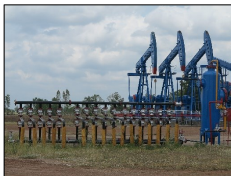
3) แผงวาล์วควบคุมการไหล (Valve Panel)
