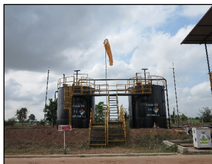
6) ถังเก็บน้ำมันดิบ (Crude Oil Tank)
