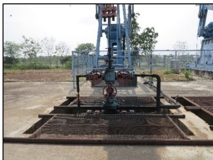
1) อุปกรณ์ชุดหัวปากหลุม (Well Head Unit)
