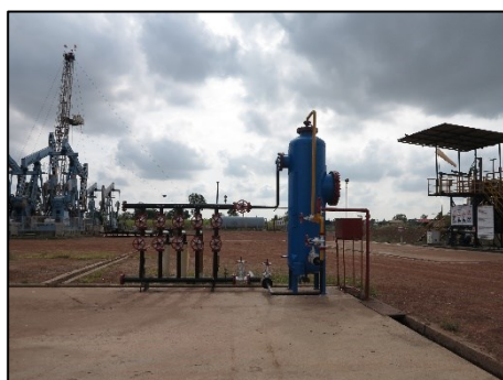
3) แผงวาล์วควบคุมการไหล (Valve Panel)
