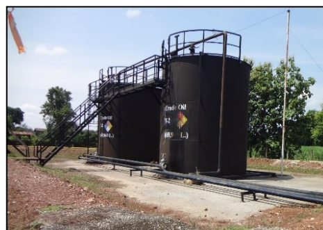
6) ถังเก็บน้ำมันดิบ (Crude Oil Tank)
